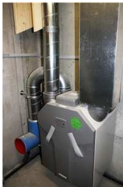
Die kontrollierte Lüftung verteilt Frischluft und Wärme im ganzen Haus.
